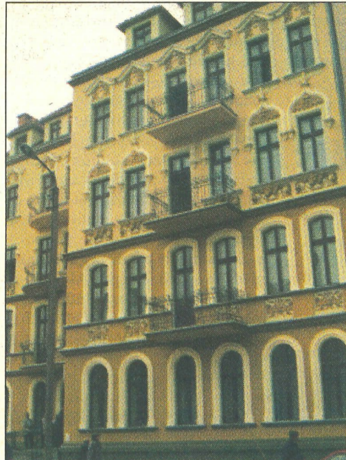
Siedziba DRKCH po remoncie. Zadowoleni z nowego budynku pracownicy stoją na podjeździe dla inwalidów.
