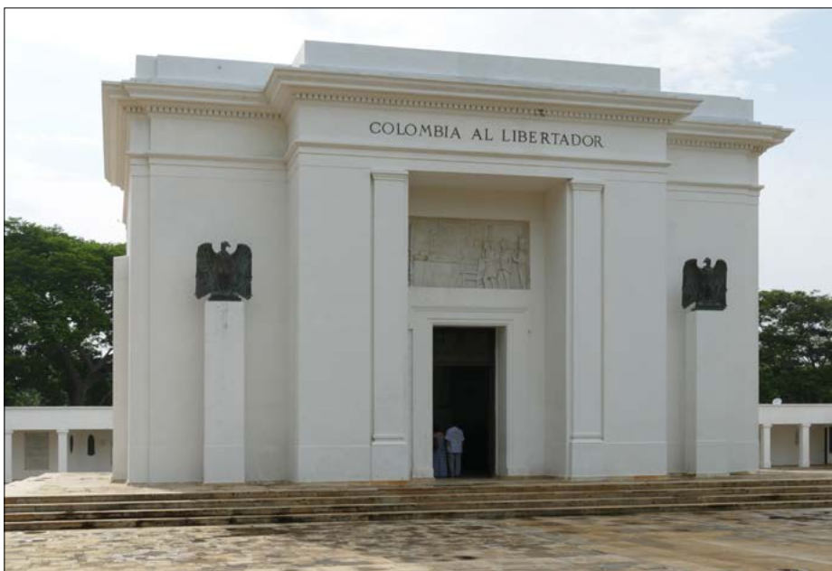
Mauzoleum Bolívara w pobliżu Santa Marta
