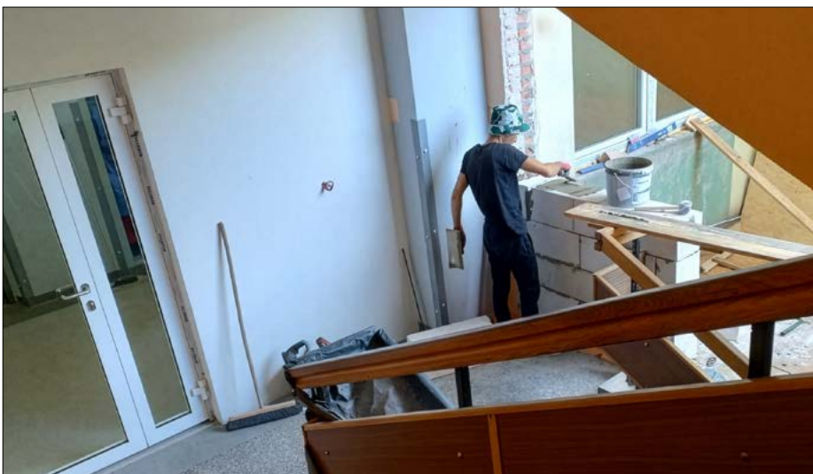
W szpitalu ciągle trwają remonty
