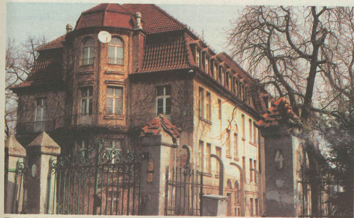
W tym budynku przy ul. K. Bartla 5 mieści się m.in. Zakład Ratownictwa Medycznego AM.
