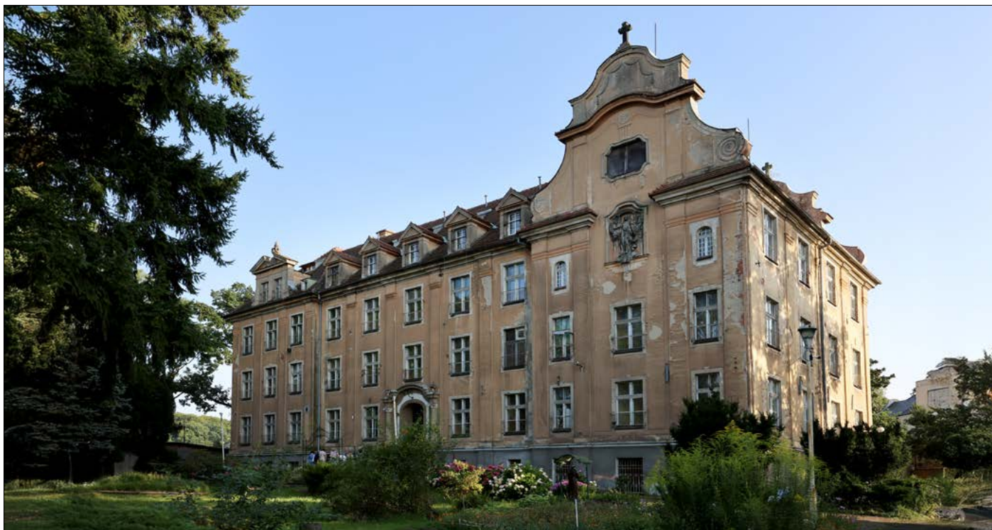
Tak obecnie wygląda budynek dawnego sanatorium
