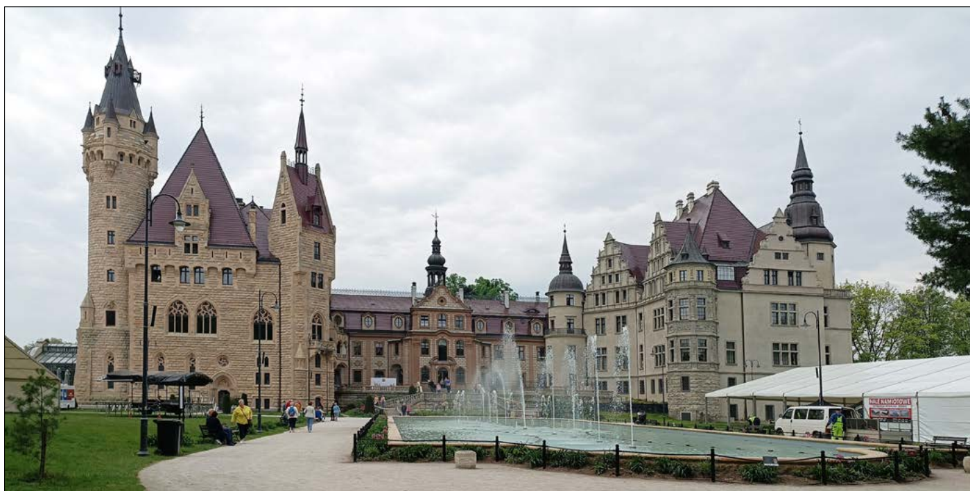
Pałac od strony południowo-wschodniej
