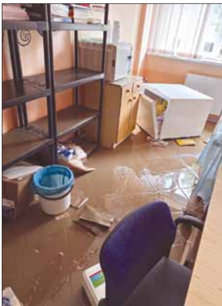
Zniszczony gabinet lekarski w Bardzie
