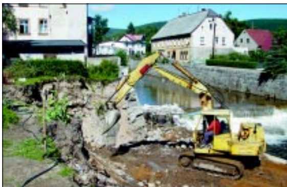
Prace przy odbudowie umocnień w Piechowicach.
