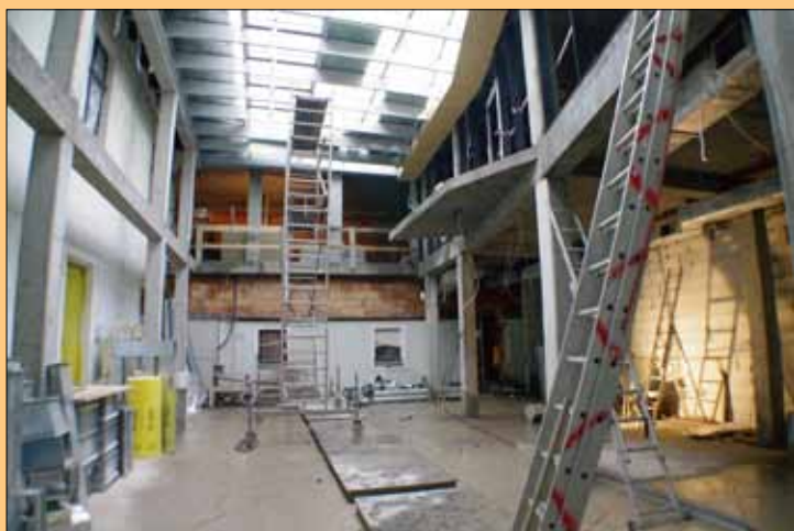
Nowa sala konferencyjna nad dawnym patio
